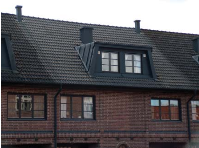
Tak med svarta betongpannor. Radhus med gemensamt tak. 2 år efter behandling med Grön-Fri.
