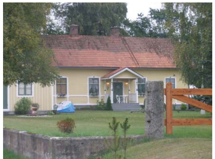
Här är ett tegeltak där man inte nådde så långt. Rätt utrustning såsom stege, sprututrustning, förlängningslans samt skyddsutrustning behövs för ett bra resultat.
