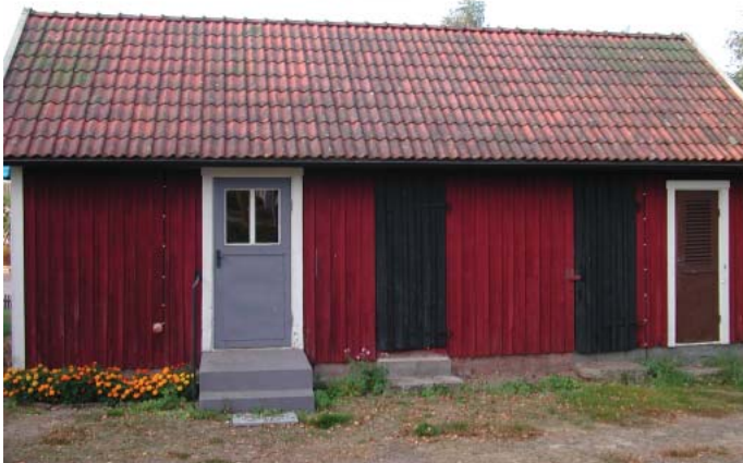
Tak med tegelpannor. Bilden är tagen 5 år innan bilden till höger, dvs 3 år innan behandlingen med Grön-Fri. Här kan även tillväxten av alger jämföras på en obehandlad yta.
