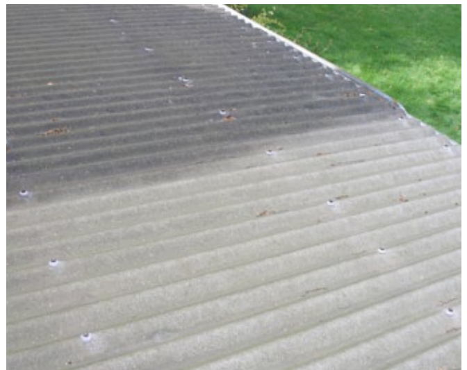
Tak av helgenomskinlig glasfiber med angrepp av alger. 2 år efter behandling av Grön-Fri. Inget efterarbete.
