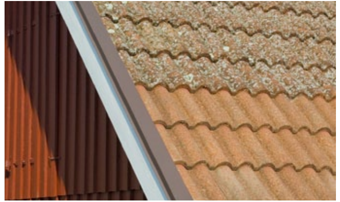
Tak av betongpannor med angrepp av lav. Två år efter behandling av Grön-Fri. Inget efterarbete.
