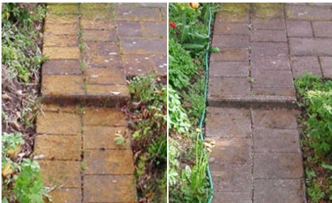
Gångplattor med angrepp av mossa behandlad med Grön-Fri. Inget efterarbete. Vänster: 1 månad efter behandling. Höger: 1 år efter behandling.
