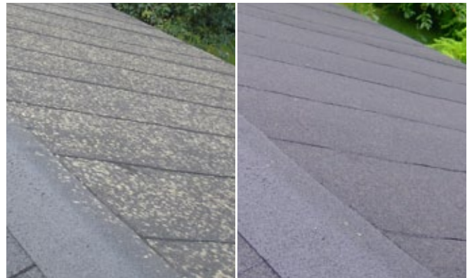
Tak av papp med angrepp av lav. 3 år efter behandling av Grön-Fri. Inget efterarbete.
